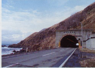
湯泊トンネル
